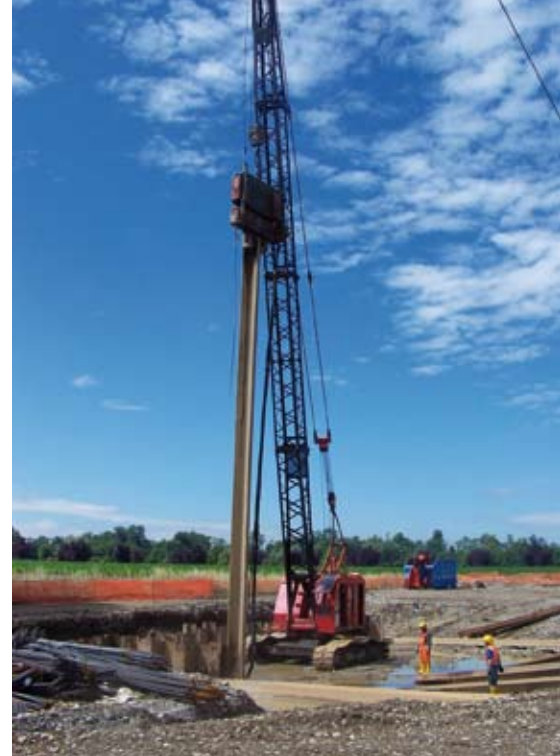
Cantiere 2 - Urago d'Oglio: infissione palancole metalliche per la realizzazione di un plinto di fondazione del viadotto Oglio; a destra, elevazione delle pile del viadotto
