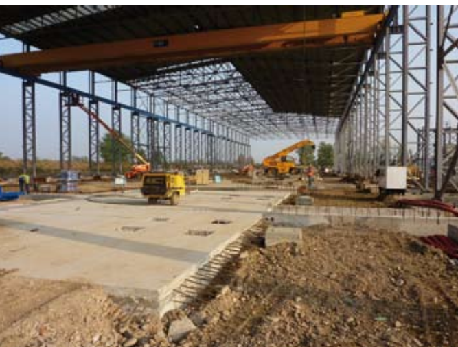
Cantiere 2 - Fara Olivana: costruzione del capannone di prefabbricazione e centrale di betonaggio del Cantiere Logistico
