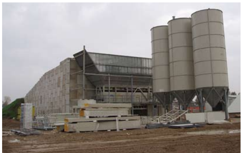
Cantiere 2 - Fara Olivana: costruzione del capannone di prefabbricazione e centrale di betonaggio del Cantiere Logistico
