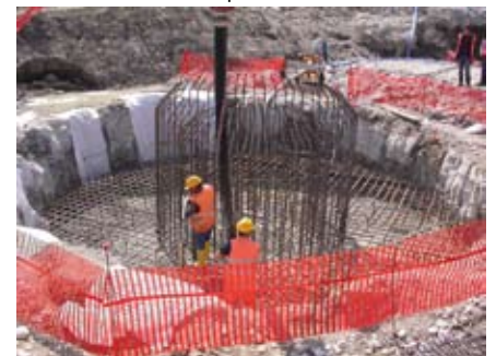
Cantiere 3 - Cassano d'Adda: Concio prefabbricato del viadotto Adda e getto del plinto di fondazione delle pile del viadotto Adda
