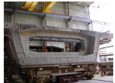
Cantiere 3 - Cassano d'Adda: Concio prefabbricato del viadotto Adda e getto del plinto di fondazione delle pile del viadotto Adda
