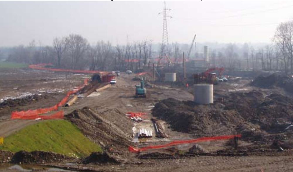
Cantiere 2 - Urago d'Oglio: infissione palancole metalliche per la realizzazione di un plinto di fondazione del viadotto Oglio; a destra, elevazione delle pile del viadotto
