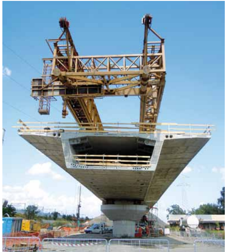
La seconda stampella in fase di costruzione
