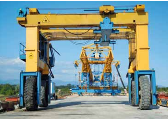
Il cosiddetto "elefante" che trasla i conci in arrivo in cantiere fino al carro di varo
