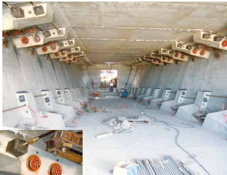
Viadotto Oglio, interno dell'impalcato in costruzione
