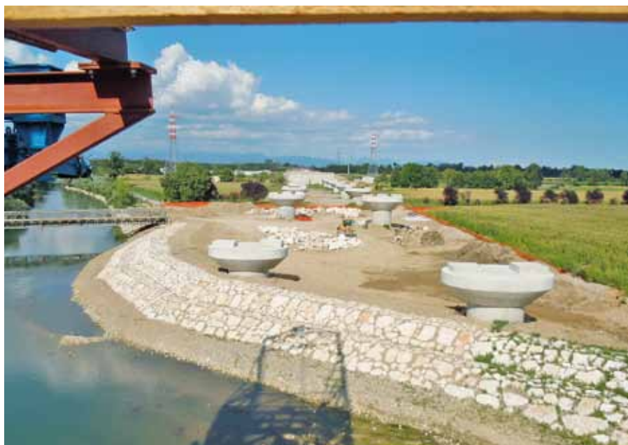
Viadotto Oglio: le pile pronte per lo scavalco del fiume
