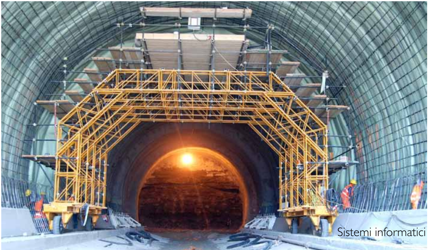
Vedute di cantieri di costruzione opere infrastrutturali e scavo di gallerie naturali
