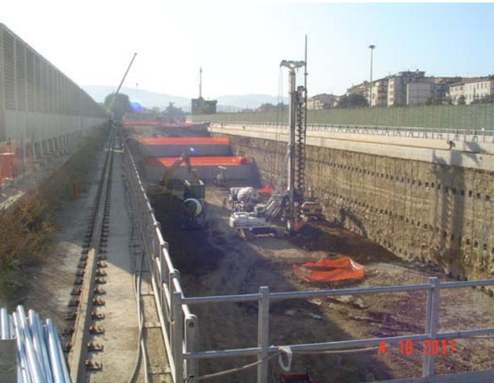
Il grande camerone che accoglierà la TBM (passante)
