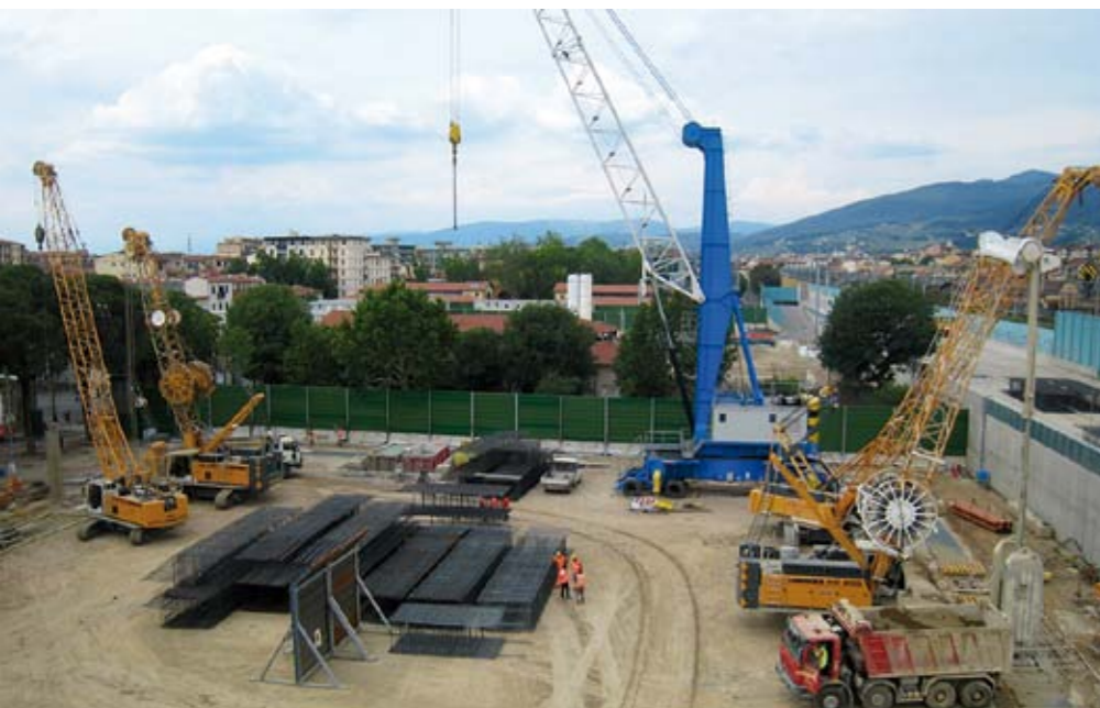
Lavori di preparazione per la realizzazione della nuova Stazione AV
